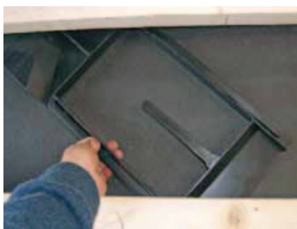
Det øverste element monteres imellem lægten og undertag.
