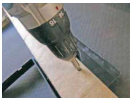
Der skrues 2 stk. max. 45 mm. lange skruer igennem lægten og ned i overkant af undertagskraven. Ribberne på undersiden af kraven sikrer at der ikke kan komme kontakt imellem undertag og skruer.
