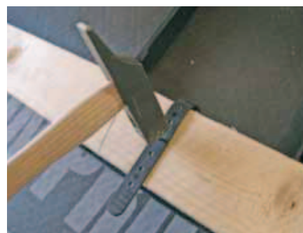
Flap fastgøres med de medfølgende fladhovedede søm.
