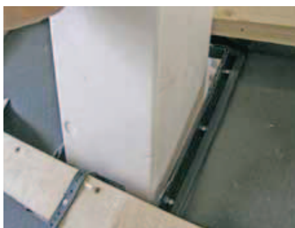
Isorør puttes igennem rørgennemføringen. For at lukke luftstrømme omkring isorøret kan der skummes omkring isorøret eller fyldes ud med traditionel isolering.
