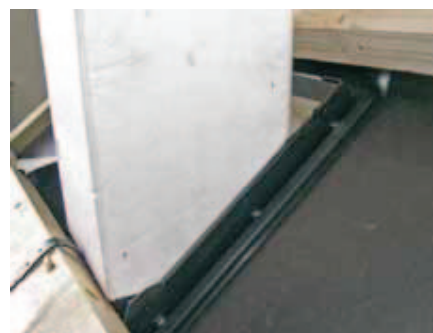
Undertagskraven færdigmonteret set ude fra.
