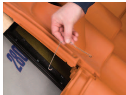
Bundstenen bindes med en sidefaldsbinder.
