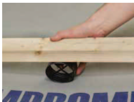
Undertagsstrammerne føres ned mellem undertag og lægte.
