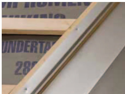
Trekantskilen monteres på 100 % rene og tørre flader.
