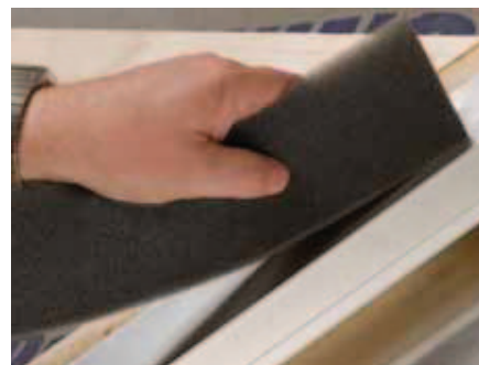
Trekantskilen monteres på skotrende-foden.
